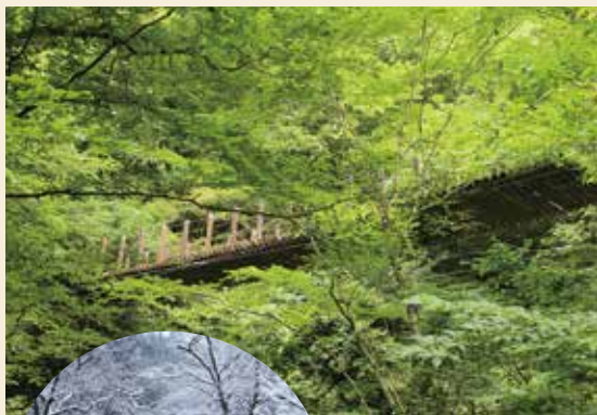
新緑の汐見滝吊り橋
